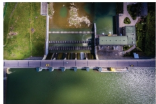
Elektrownia szczytowo-pompowa Porąbka-Żar
