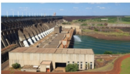
Zapora i hydroelektrownia Itaipu
