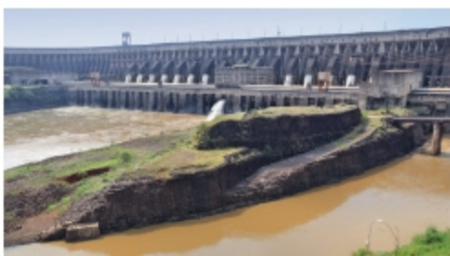
Zapora i hydroelektrownia Itaipu
