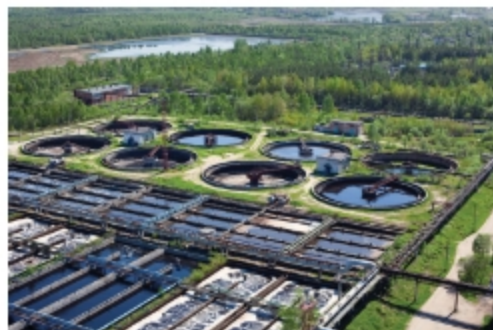
Biologiczna oczyszczalnia wody
