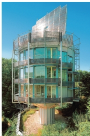
Heliotrop - pierwszy na świecie budynek plusenergetyczny
