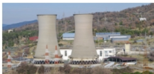
Larderello Geothermal Complex (Włochy)
