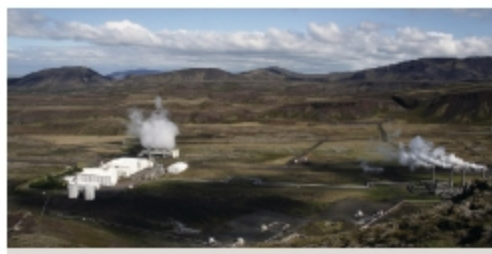
Elektrownia geotermalna Nesjavellir (Islandia)
